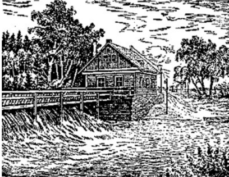
Figura 43. Central hidroeléctrica de un artel agrícola de Burmakin; genera 80 kilovatios de potencia y suministra energía a siete koljoces.
